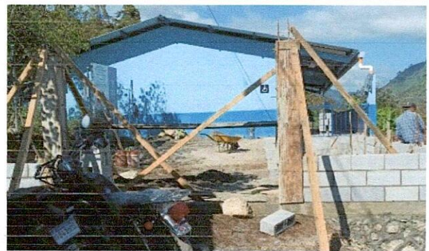
Foto 4: FUNDICIÓN DE COLUMNAS PARA LA COLOCACIÓN DEL PORTON DE ENTRADA DE LA ESCUELITA DE PREPRIMARIA
