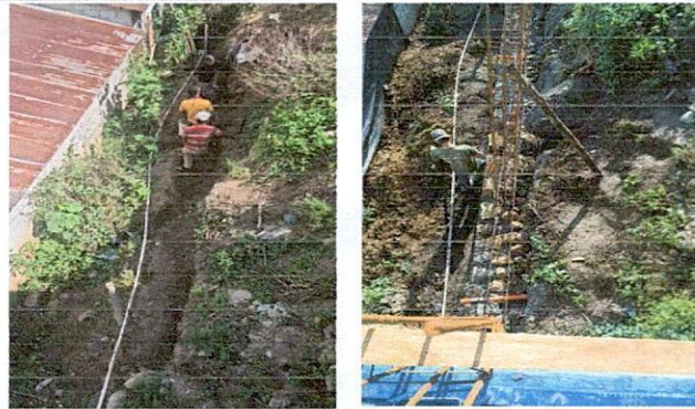
Foto1: FUNDICIÓN DE BASES Y MURO DE CICLOPEO
