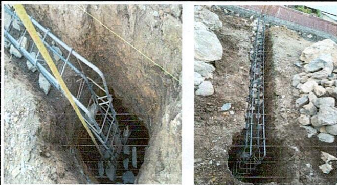
Foto 3: FUNDICIÓN DE CINCHOS PARA SUJETAR EL MURO CICLOPEO
