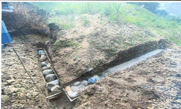
Foto 5: FUNDICIÓN PARA LEVANTAR PARED EN LA PARTE TRASERA DE LA ESCUELITA DE PREPRIMARIA
