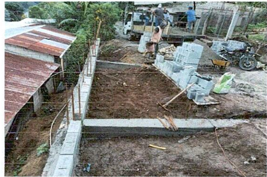
Foto 2: COLOCACIÓN DE BLOCK PARA LA CIRCULACIÓN DEL PREVIO
